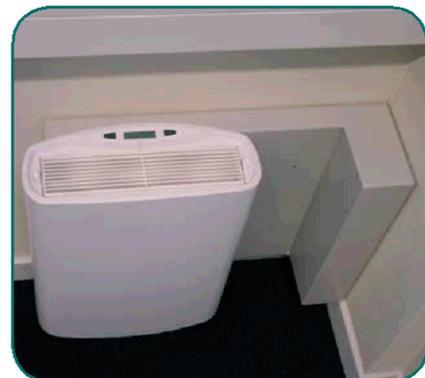
Prinzipdarstellung der Montage bei "Seitenwandmontage"
